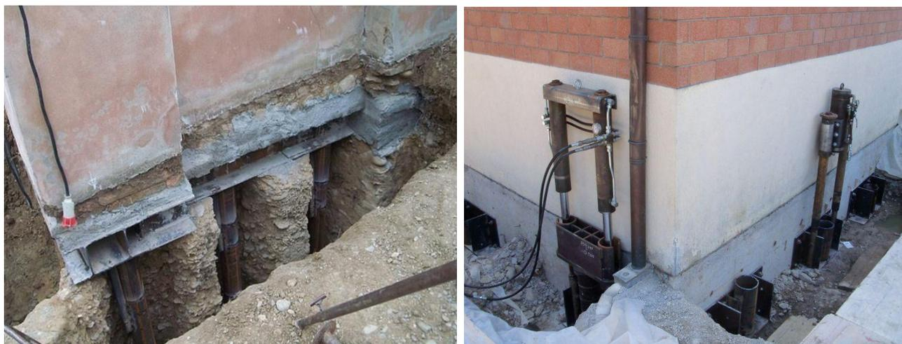
**Figura 7** - Esempio di sostegno/rinforzo delle fondazioni in muratura con una trave in acciaio su micropali. A destra sollevamento e sostegno della trave di fondazione in c.a. di un fabbricato mediante micropali infissi collegati con piastre in acciaio alla trave stessa – Foto ditta Cusi snc di Reggio Emilia.
